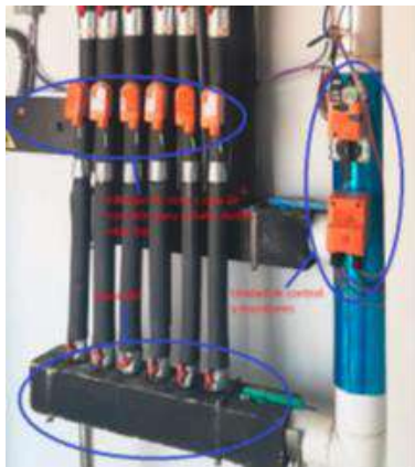
Figura 7 Montaje de sistema de control hidrónico Multizona y resultado de 9 meses de toma de datos.
