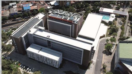
Sistema solar fotovoltaico de 200 kWp
