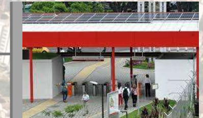
Sistema solar fotovoltaico de 50 kWp
